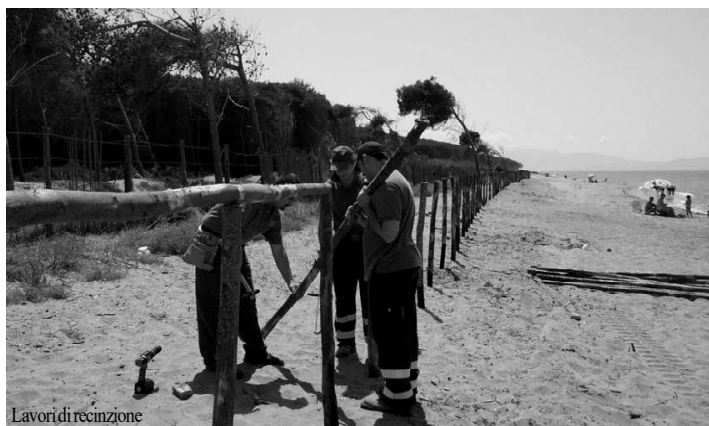
Lavori di recinzione
